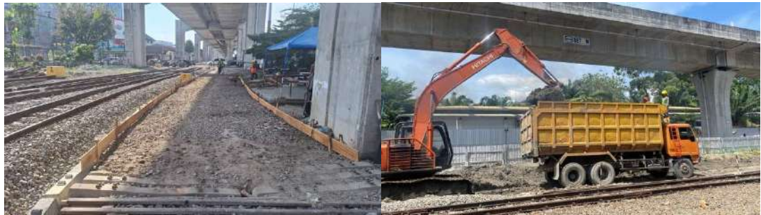
Gambar 2. 4 Dokumentasi Progress Kegiatan Pembangunan JLKAMB
