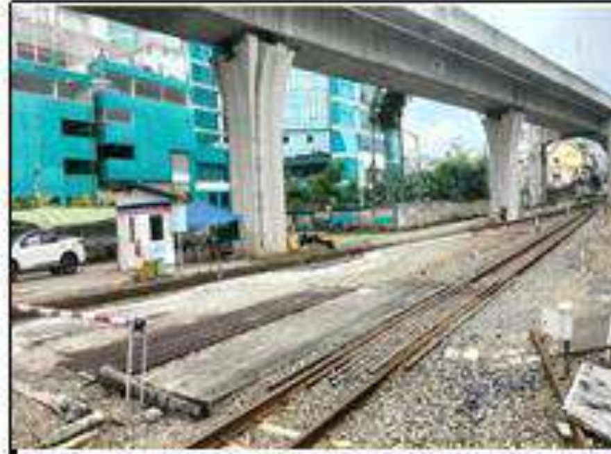
Akses jalan Selatan
